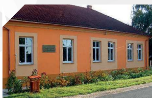
Nagybjomi Kolping Katolikus Szakközépiskola és Kollégium
